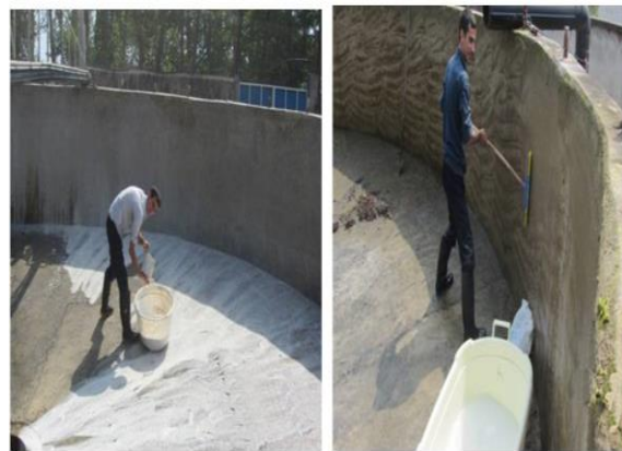
شکل ۵: شستشو و آهک‌پاشی حوضچه‌های رسوب‌گیر
